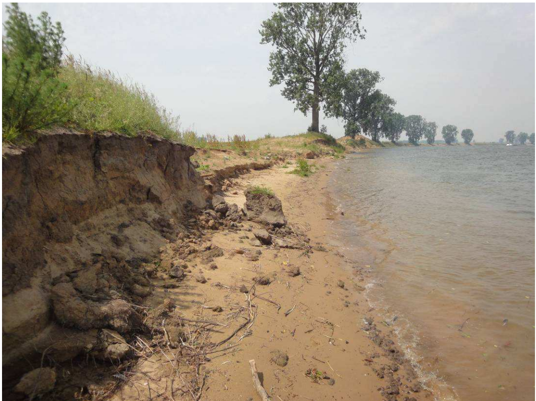
Verlaagde instroom hoogwatergeul (foto Bart Peters).
