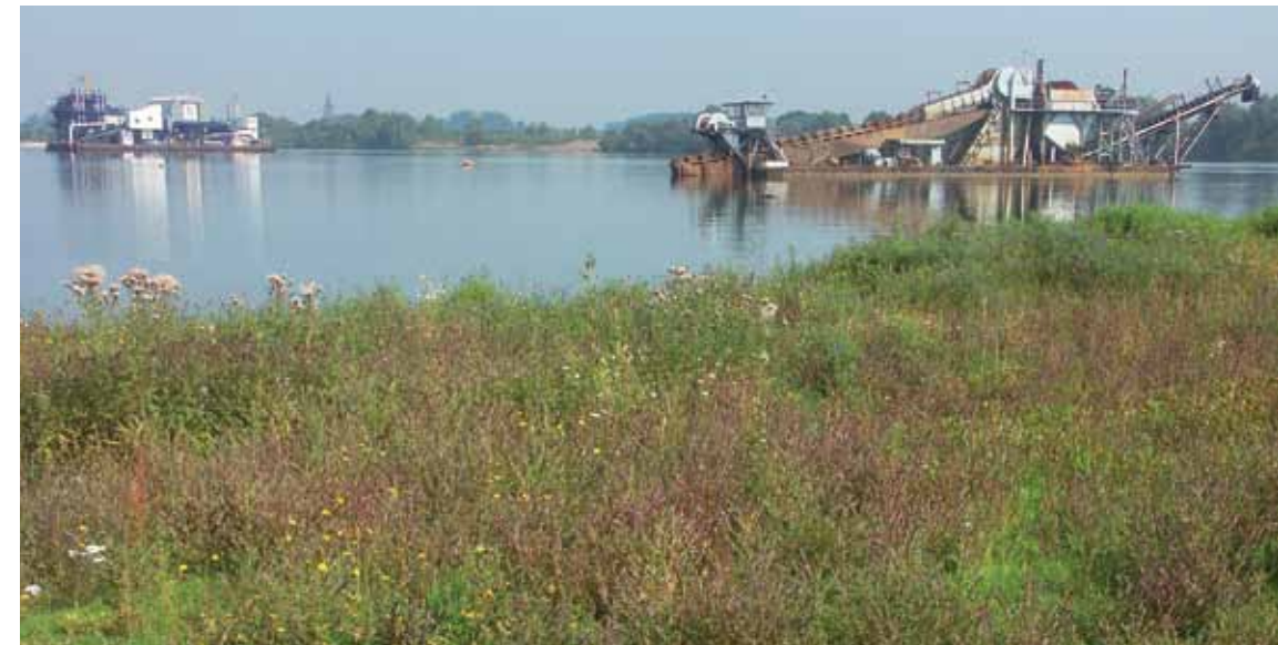
Diepe zandwinning in het Maasplassengebied.
