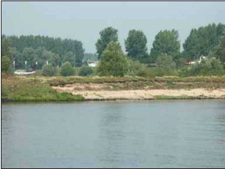
Erosie van de scheidingsdam van de Zandmeren; uiteindelijk kan een zandige oeverwal/zandplaat ontstaan
