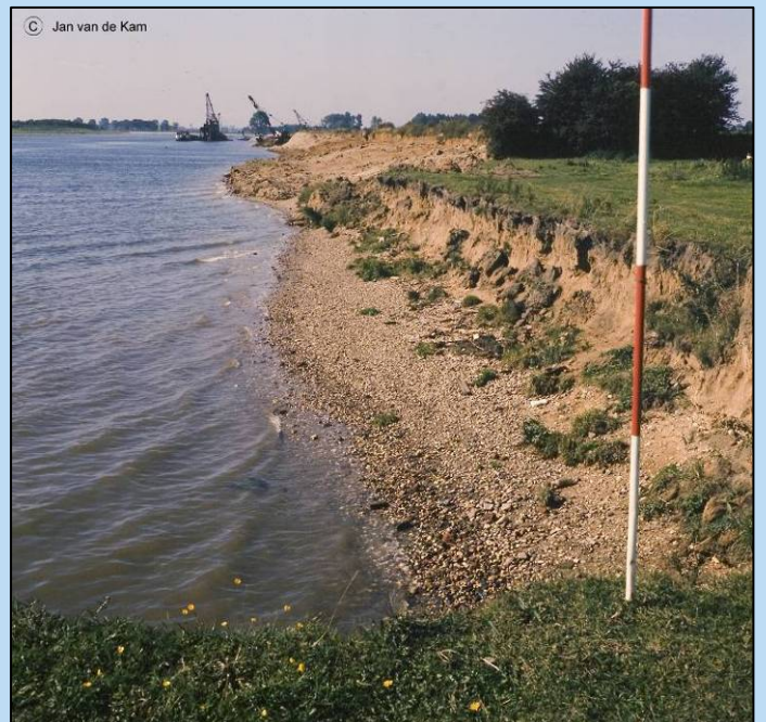
Beelden van de nog niet verdedigde Maasoeveren van rond 1974 bij Gennepe (linksboven), Boxmeer (rechtsboven), Oeffelt (linksonder) en Kessel (rechtsonder). De foto bij Kessel toont de normalisatiewerkzaamheden waarbij het oever talud onder een vast talud werd afgewerkt en verstevigd met aanvankelijk vaak grind, later breuksteen (foto's Jan van de Kam, Griendtsveen).
