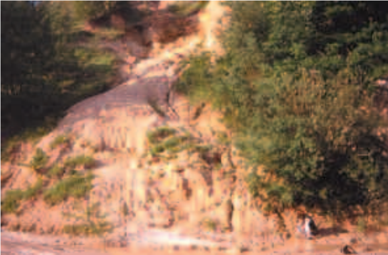
20 Waar dekgrondpakketten afschuiven door de druk van het grondwater vormen zich grote puinwaaiers die ook gedurende de zomer heel constant water afgeven.
